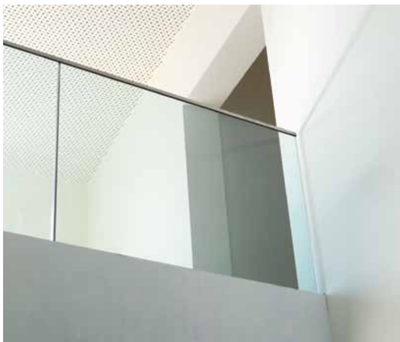
Un installazione di parapetto Glass U a pavimento - An installation of Glass U railing to the floor
