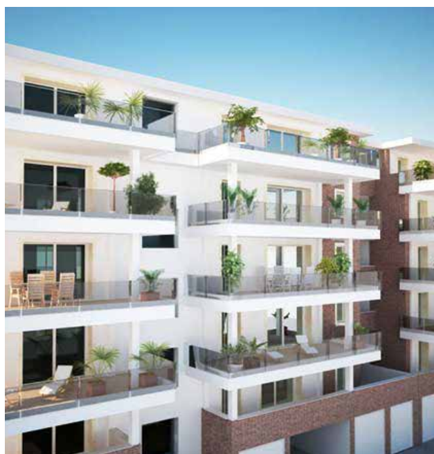
Smart Village Murialdo vista degli edifici in Classe CasaClima A+
