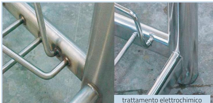
elettrochimica fa parte dei procedimenti di finitura che asportano materiale con il passaggio di elettricità come descritto nelle norme VDI 3401.
