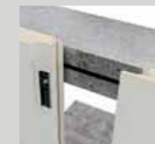
Montaggio dei pannelli in senso verticale
