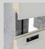
Montaggio dei pannelli in senso orizzontale
