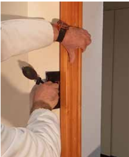
Inserire il cuneo pneumatico Winbag tra il serramento ed il controtelaio
