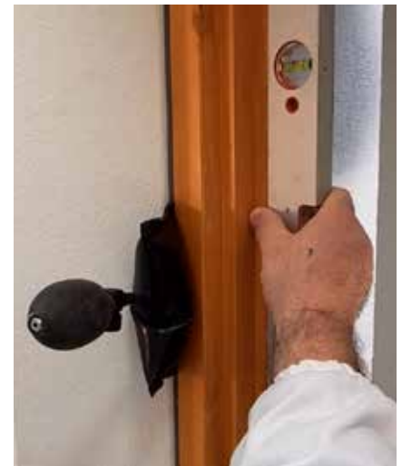
Verificare infine la corretta messa in bolla con l'aiuto di una livella
